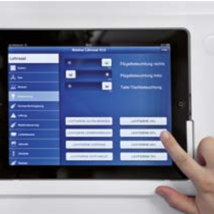
Desde aquí se pueden controlar todas las funciones de conmutación del aula mediante pulsadores, pantalla táctil o iPad.
